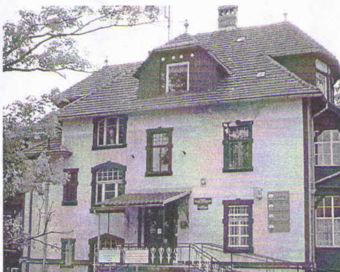
Oczekiwana od wielu lat wymiana pokrycia dachowego na świeradowskim magistracie zostanie dokonana - jak wszystko na to wskazuje - jeszcze w tym roku.
