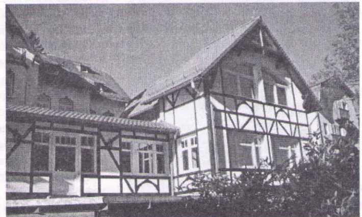
Widoczny na zdjęciu fragment Park Hotelu to dobudowana niedawno część restauracyjna. Lokal będzie miał 100 miejsc, osobne wejście i oficjalnie przyjmie gości do połowy października; grzejniki muszą otrzymać ciepło z kotłowni znajdującej się w remontowanym obecnie budynku dawnej prziodni, która wiosną przyszłego roku stanie się częścią kompleksu hotelowego.
