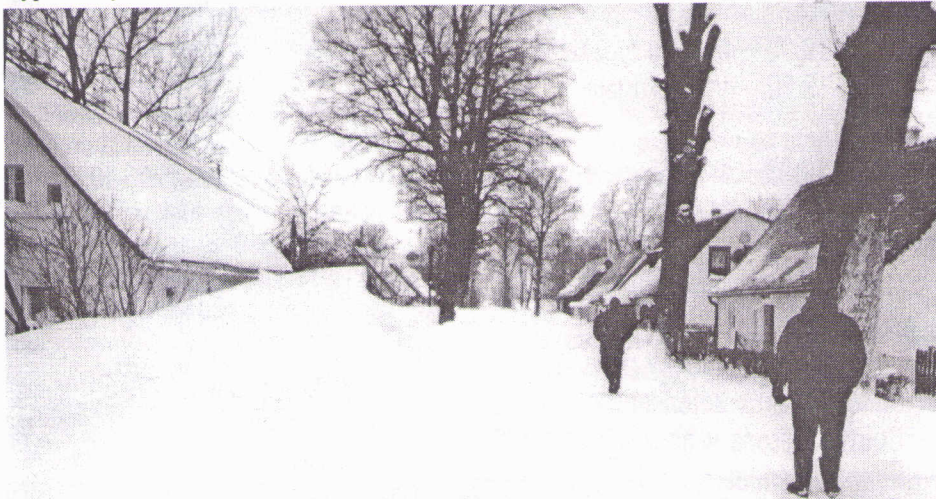
Ul. Główna między Czerniawą a Pobiedną - widać, jak „jeźory” śniegu sięgają poziomu dolnej krawędzi dachu. Gdy robiono to zdjęcie, droga była całkowicie nieprzejezdna.
