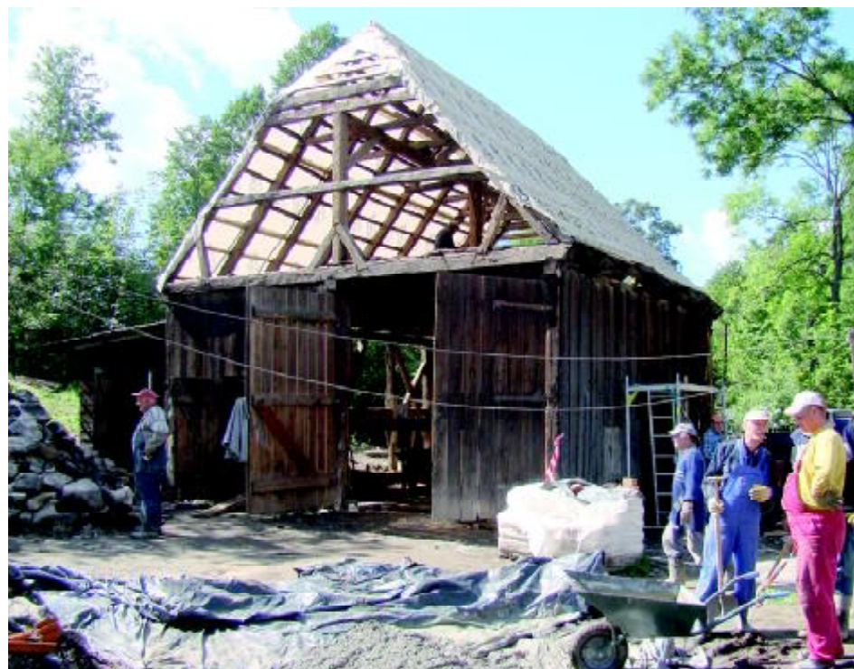
Stara stodoła miała na tyle zdrową więźbę dachową, że uniesie nowe pokrycie nad przyszłym grillowiskiem.
