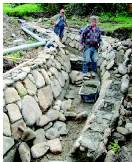
W takim korycie, wyłożonym kamieniami pozyskanymi z robót ziemnych przy młynie, popłynie strumień, który swym szmerem będzie kołować zmięte ucho turysty.
