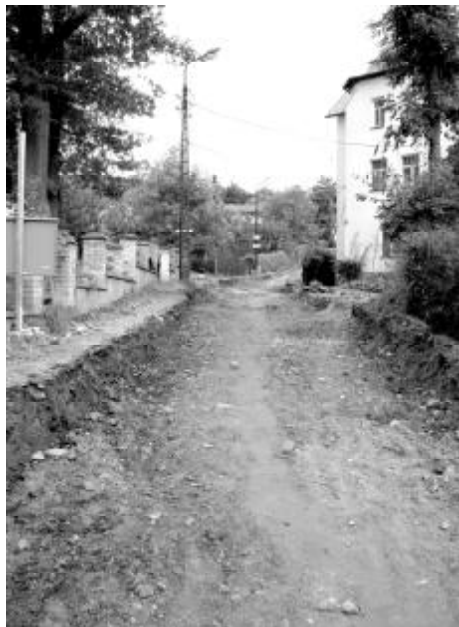
Ul. Wczasowa - już wytyczona
