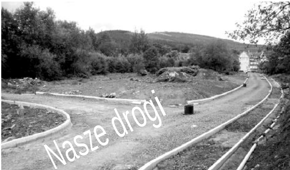
Łączniki Wyszyńskiego/Zdrojowa/Piastowska już po naprawach powodziowych uszkodzeń.
