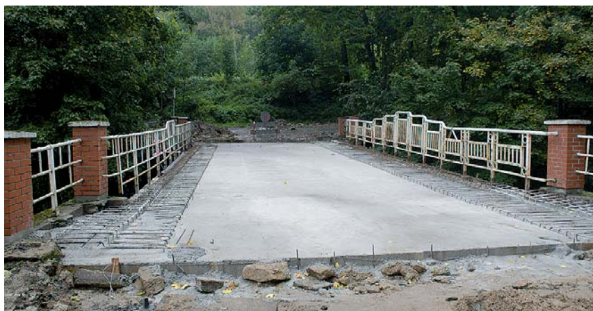
Najpierw na moście ułożono nowe zbrojenie (fot. u góry) i zalano je betonem (fot. powyżej).
