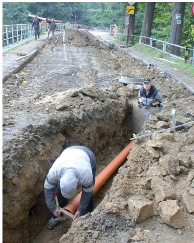
Przy okazji wymieniono starą instalację burzową.
