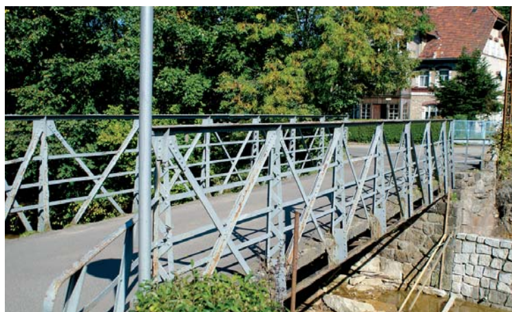
I już po remoncie: na moście wylano nową nawierzchnię, ułożono chodniki, pomalowano barierki.
