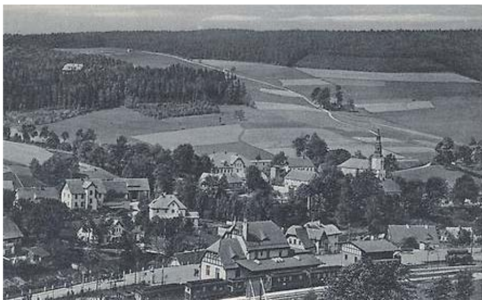
Zdjęcie wywołuje z jednej strony stan lekko wzmożonej tęsknoty za bezpowrotnie utraconą drogą żelazną, z drugiej - daje wyobrażenie o rozwojowej dynamice Świeradowa.
