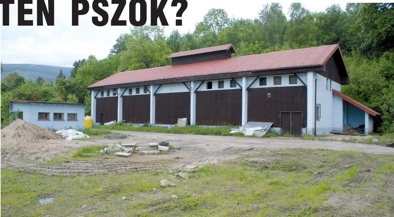
Planowana lokalizacja świeradowskiego PSZOK-u - zabudowania i teren byłej oczyszczalni ścieków przy ul. Grunwaldzkiej.
