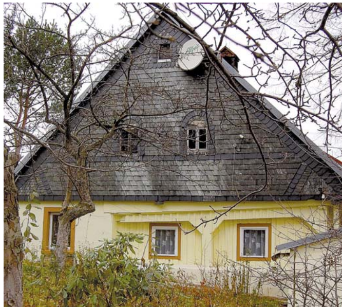
Dom przysłupowy przy ul. Kościuszki. Łupek na ścianie szczytowej nie tylko ozdobił, ale i zabezpieczał konstrukcję przed niekorzystnymi warunkami atmosferycznymi.
