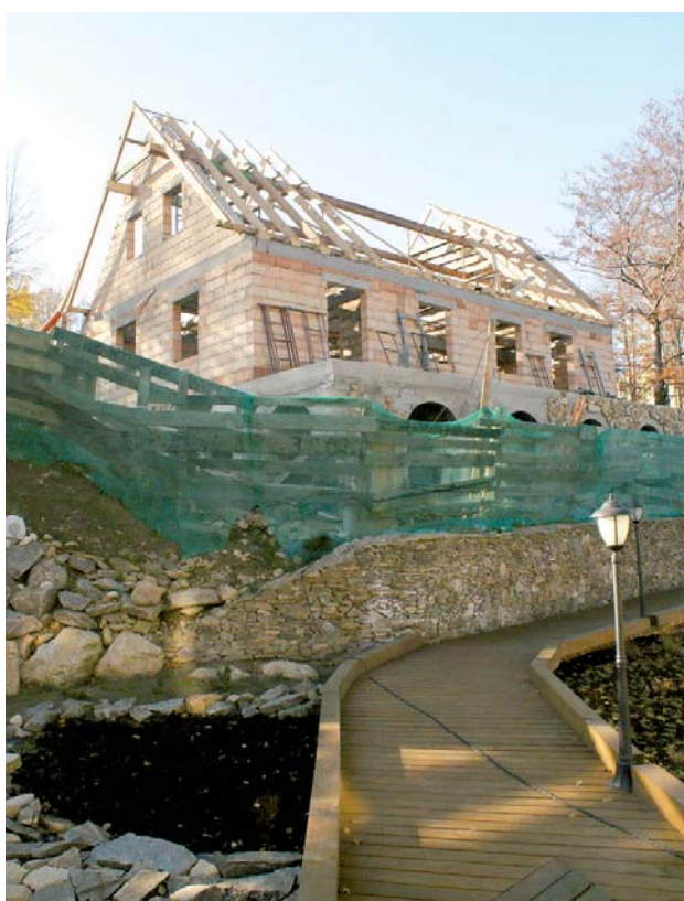
Trwa budowa Domku Drwala (przy nadleśnictwie) - część Centrum Edukacji, którego najważniejszym elementem będzie ogród dydaktyczny z modelem izerskiego torfowiska.
