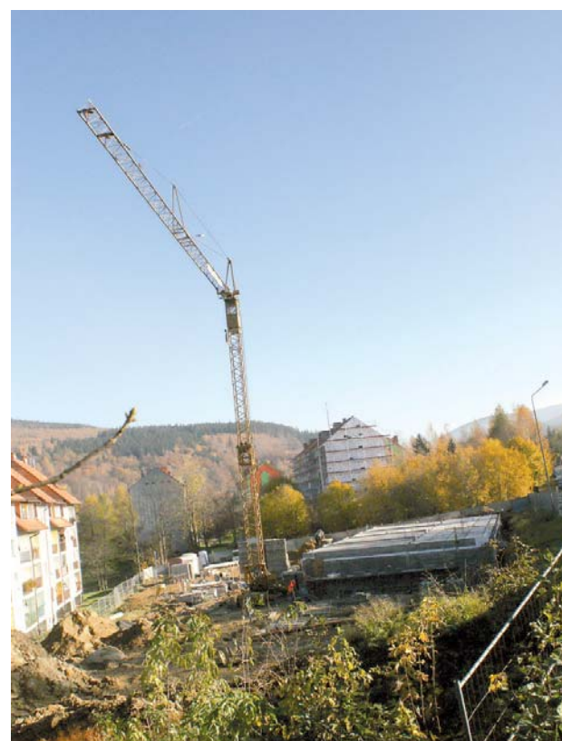
Ruszyła wreszcie budząca najwięcej społecznych kontrowersji (ostrzy sprzeciw mieszkańców os. Korczaka) budowa centrum handlowego przy ul. Wyszyńskiego.
