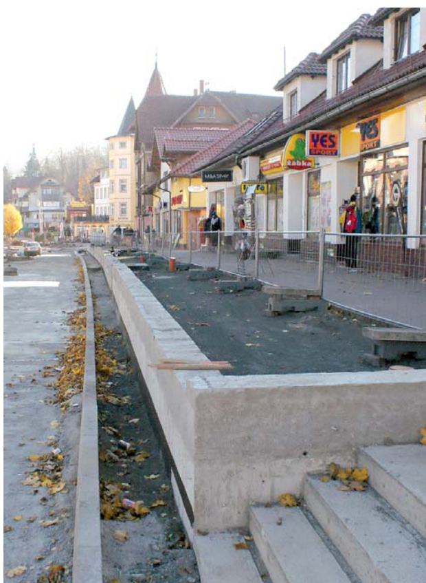
Dzięki betonowej osłonie możliwe będzie poszerzenie chodnika na ul. Zdrojowej, by w przyszłości pomieściły się tam stoliki i parasole nowo otwieranych ogródków piwnych.
