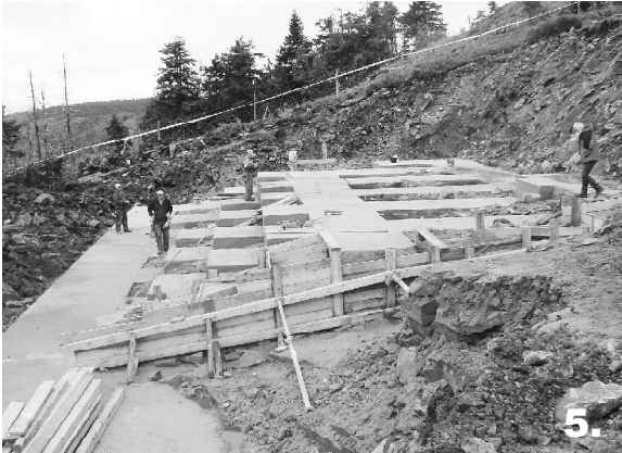
1. Lampy do oświetlenia stoku czekają. 2. Słupki pod lampy już stoją. 3. Coraz równiej na nartostradzie. 4. Kierownik budowy, Mieczysław Dąbka, dogląda kruszenia skały. 5. Ławą (fundamentową), mo-
