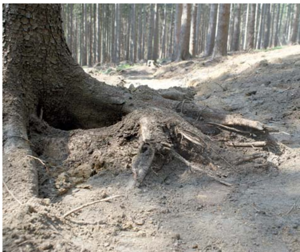
Przy wytyczaniu ścieżek nie niszczy się systemów korzeniowych, tylko delikatnie się je odsłania; potem korzenie zostaną „otulone” grubym tłuczniem (sekcja nr 1).
