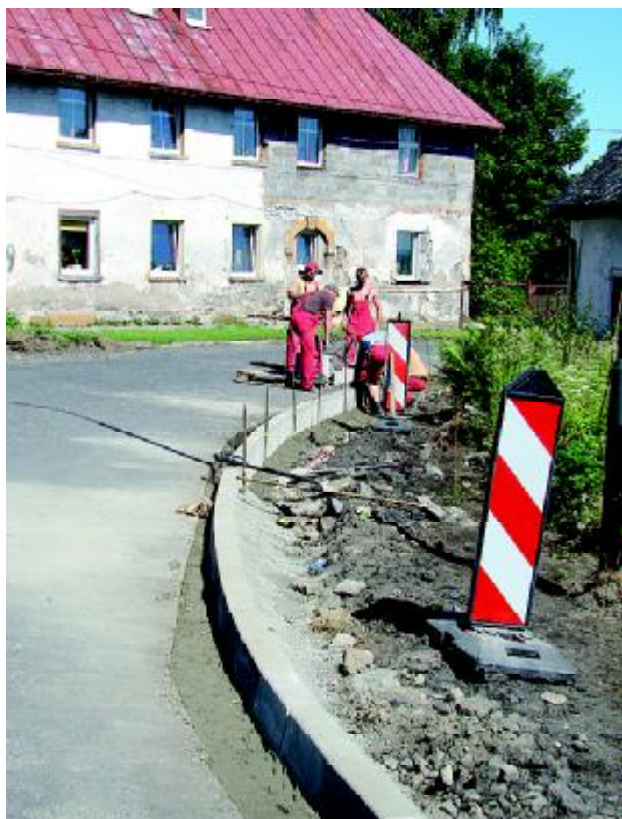
Ul. Główna w Czerniawie przebudowywana we współpracy ze starostwem lubańskim. Na długości niespełna 1 km droga zyska krawężniki i chodnik po jednej stronie.
