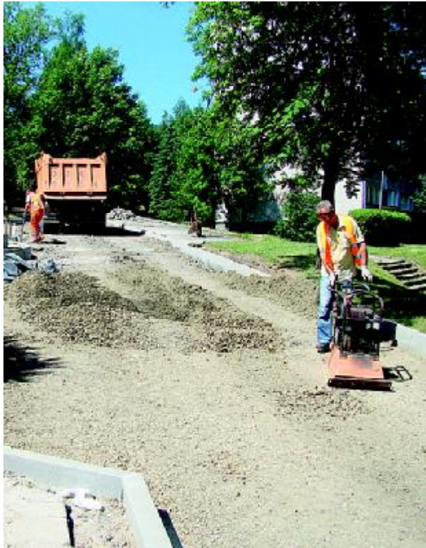
Prosty odcinek ul. Korczaka na długości blisko 200 m będzie miał nawierzchnię z kostki brukowej. Modernizację poprzedziło ułożenie nowego systemu odwodnienia.
