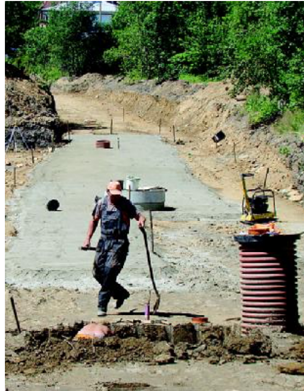
Nowa droga od ul. Wyszyńskiego do Zdrojowej zaczyna z wolna przypominać jezdnię. Odcinek na zdjęciu i 2 łączniki do ul. Piastowskiej liczyć będą w sumie 532 m.
