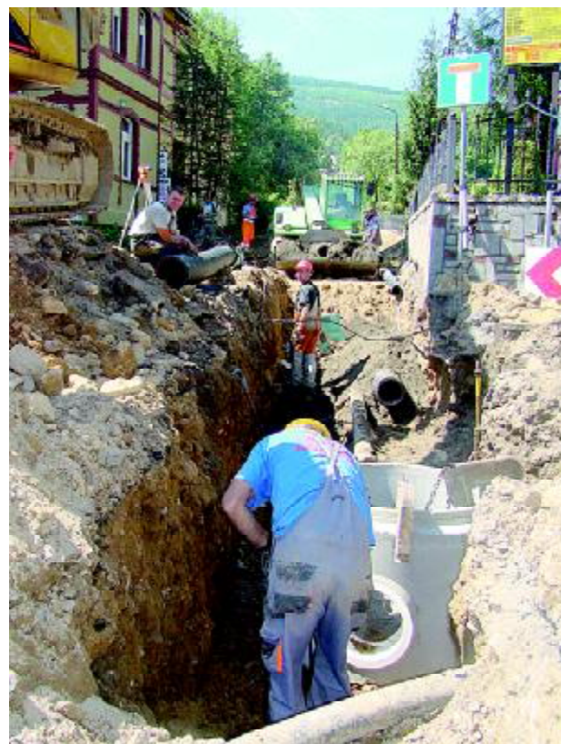
Remont ul. Sienkiewicza zaczęto od całkowitej wymiany infrastruktury podziemnej. Potem na długości 340 m (od apteki do ul. Strumykowej) pokryta zostanie asfaltem.
