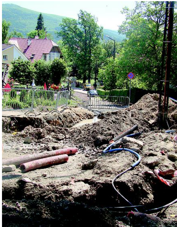
Trudno poznać ul. Wczasową, bo to etap wymiany sieci podziemnych. Docelowo na dł. 300 m będzie miała asfaltową nawierzchnię i chodnik (od „Narcyza” do „Józefa”).
