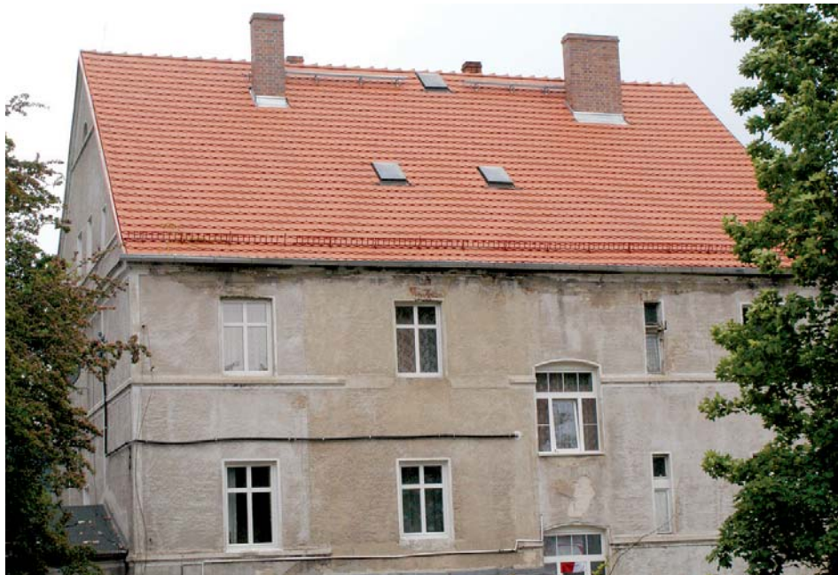
Powyżej - remont wspólnotowego budynku przy ul. Piłsudskiego 1: nowy dach, komin, obróbki... U góry - roboty elewacyjne i dachowe na budynku przy ul. Zdrojowej 12-14.
