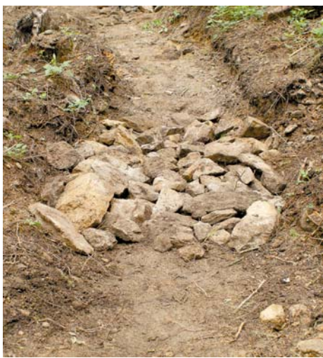
Podkład z kamieni (z odzysku) powinien skutecznie odvodnić ścieżkę.
