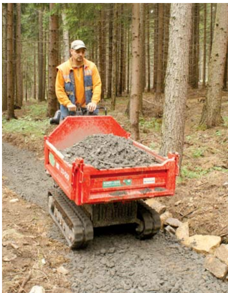
Mała wywrotka idealna na izerskie warunki. Obok kładka przerzucona nad mokradłem na ścieżce Nadleśnictwa (na Czerniawskiej Kopie).
