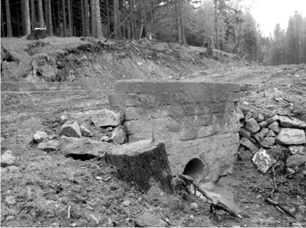
Jeden z nowych przepustów na Grzbiecie Kamienickim.
