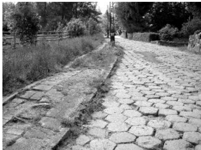
Ul. Strumykowa: chodniki zapadnięte lub wybrzuszone, zarośnięte chwastem, trylinkowa jezdnia dziurawa, doraźnie látana asfaltem.
