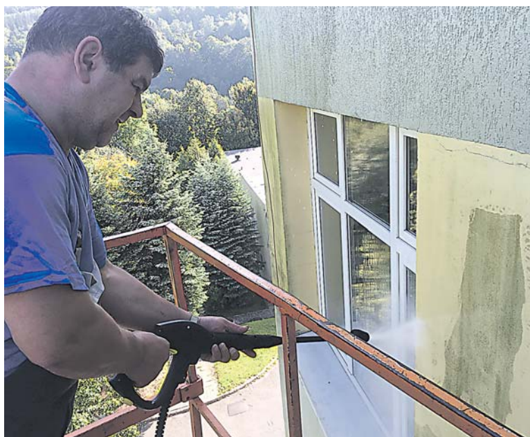
Ta ciemna plama po prawej stronie ściany pokazuje różnicę między stanem elewacji przed i po wyczyszczeniu.
