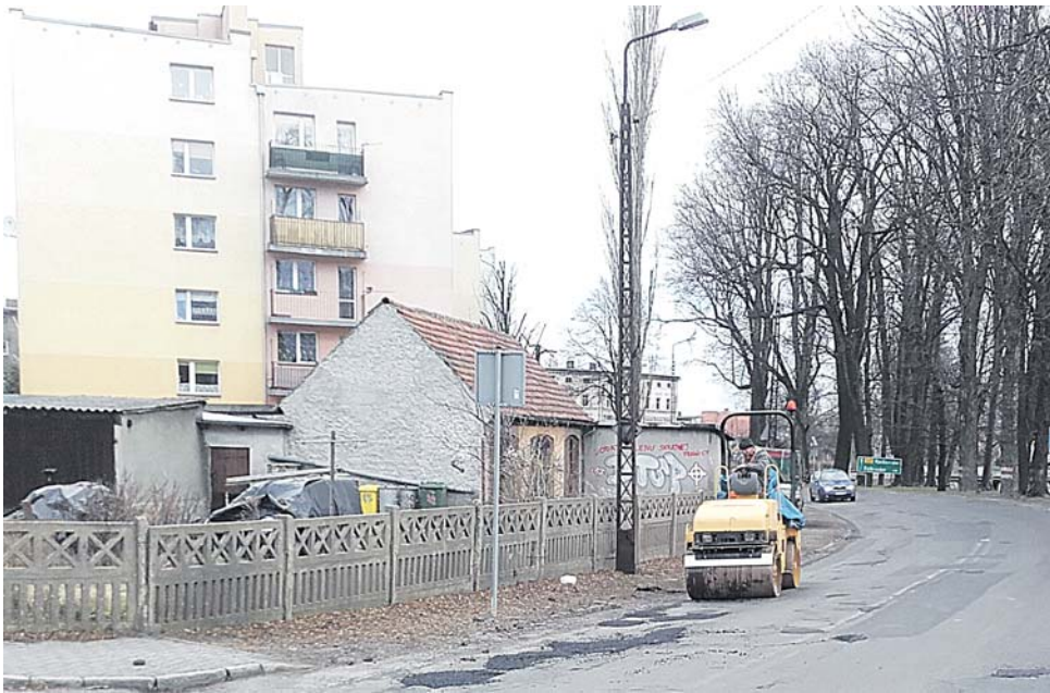
Mirsk, 6 marca, uklepywanie masy na zimno.
