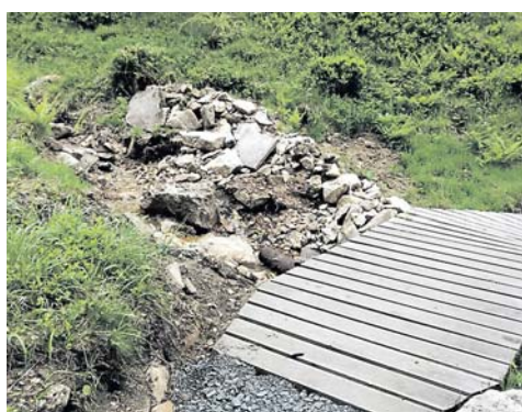
24 maja Firma Ogólno-Budowlana Marcina Skoczni z Wrocławia wykonała następu-
