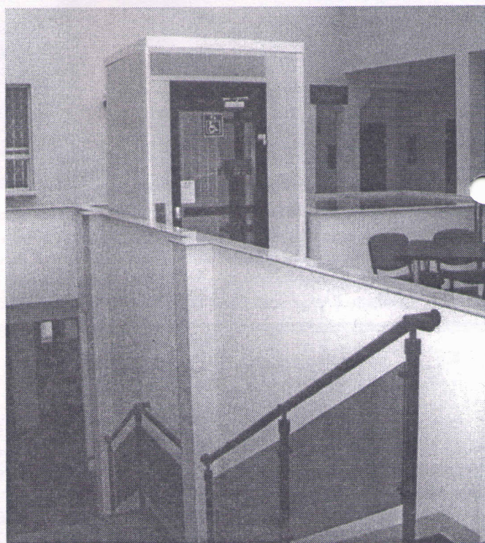
Podglądamy innych i widzimy osiągnięcia, które powinny wprawić nas we wstydlive przygnębienie – na zdjęciu winda dla niepełnosprawnych, wioząca ich z parteru na I piętro Urzędu Gminy w Zgorzelcu. Na sąsiedniej stronie u dołu: toaleta dla niepełnosprawnych w tym samym urzędzie.
