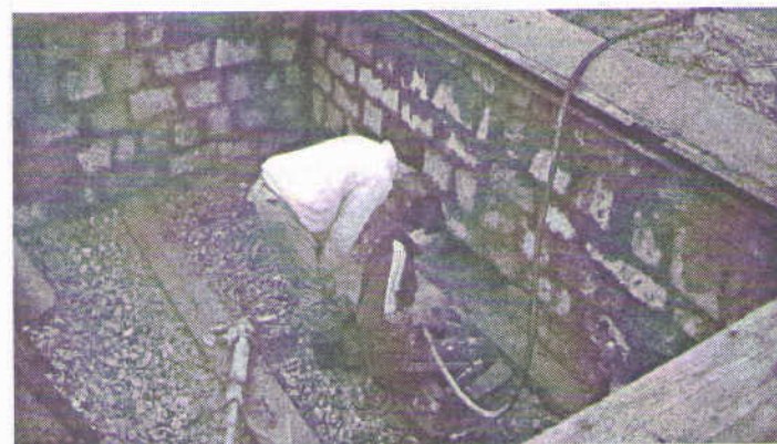
Trwają ostatnie prace w jednym ze zbiorników, skąd woda będzie pompowana do urządzeń uzdatniających.
