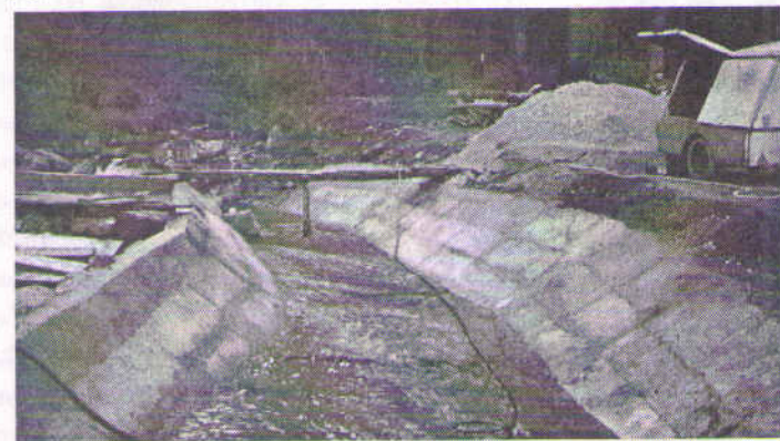
Kanał ulgi, wyłobiony przez potok, uwzględniony w projekcie, już po wybetonowaniu. Tędy popłynie nadmiar wody, omijając zbiorniki.
