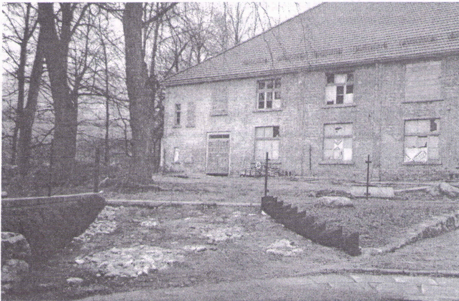
A w przylegającym do siedziby ZGM budynku, gdzie dawniej znajdowała się sala widowiskowa MOK, nie wiadomo, co nowy właściciel chce tam urządzić, kiedy, za ile i w ogóle - dla kogo. Na razie zaczął stawiać ogrodzenie i palisadę po obu stronach nie istniejącego wjazdu na rozgrzebanym placu budowy.
