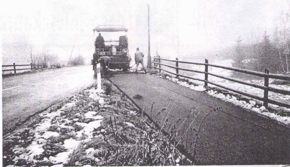
Przysłowiowym rzutem na taśmę udało się, dokładnie w dniu św. Mikołaja - między jednym a drugim atakiem mrozów, położyć ostatnie metry dywanika asfaltowego. Na zdjęciu układanie ostatnich metrów dywanika łączącego ulice Chopina z Nadbrzeżną.
