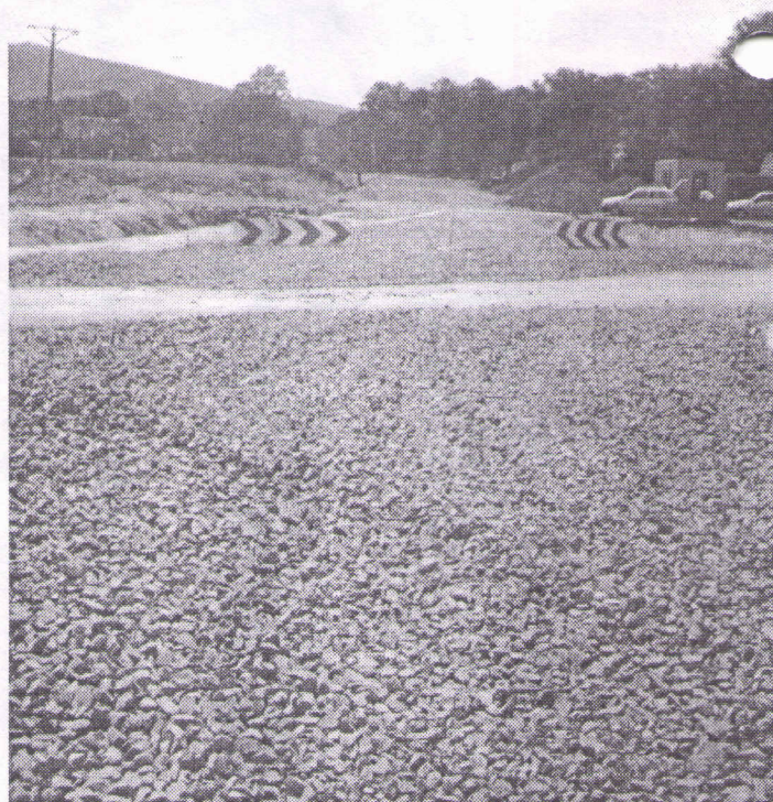
Budowę drogi 361 w Czerniawie nabrała rozpędu, wyznaczono objazdy, a wykonawca zapewnia, że do 8 lipca znów pojadą tędy samochody.
