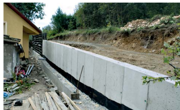
Budowa od podstaw ul. Kilińskiego okazała się dużym wyzwaniem inżynierskim, jakiego w świeradowskiej skali jeszcze nie było. Po lewej - montaż zbrojenia pod mur oporowy. Po prawej - tak prezentuje się ów mur po usunięciu szalunków.
