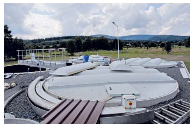
Na oczyszczalni ścieków w Czerniawie trwają prace końcowe. Po lewej - uporządkowane otoczenie wokół budynków. Po prawej - na zbiornikach głównych położone zostały pokrywy hermetyzujące, które zapobiegą emisji przykrych zapachów.
