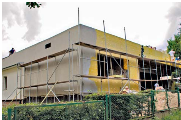
Biblioteka nabrała kształtów, ściany są już ocieplone.
