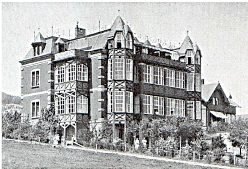
„Villa Augusta” (źródło - dolnyslask.org) - w takim stanie powinniśmy oglądać ten budynek, niestety, widzimy tylko to, co z niej zostało (fot. po prawej).
