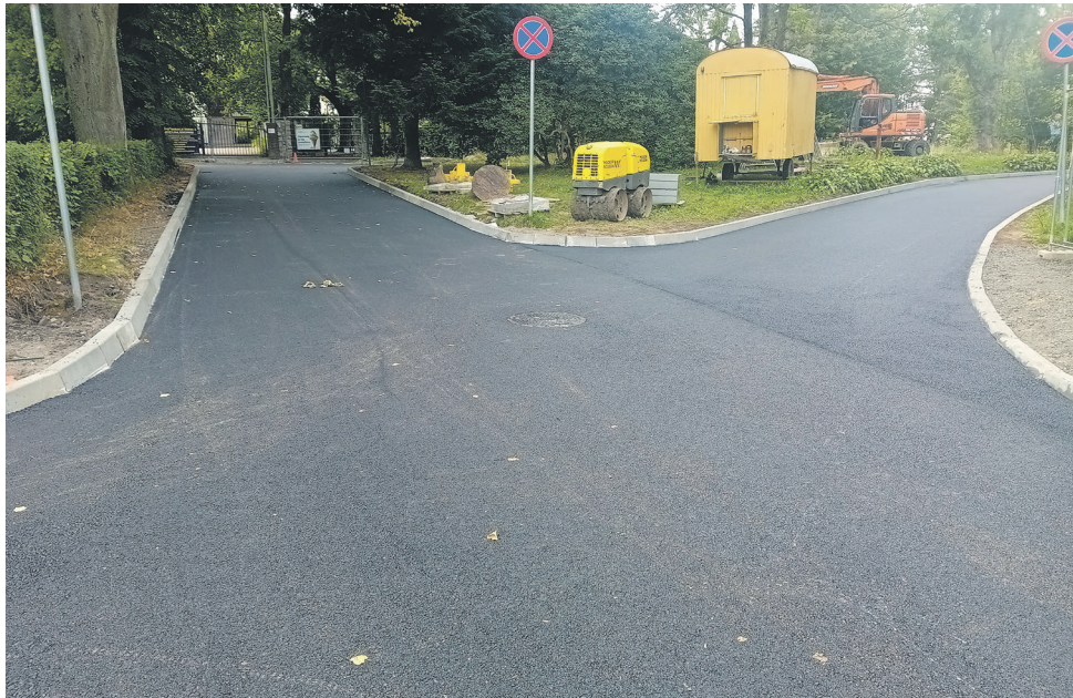
Fragment wyremontowanej ulicy Batorego foto z arch. Urzędu Miasta Świeradów-Zdrój
