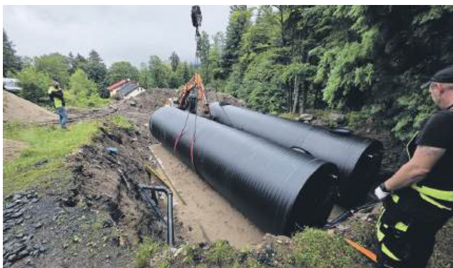
Na zdjęciu montaż zbiorników na ujęciu „Wrzos” foto z arch. Urzędu Miasta Świeradów-Zdrój
