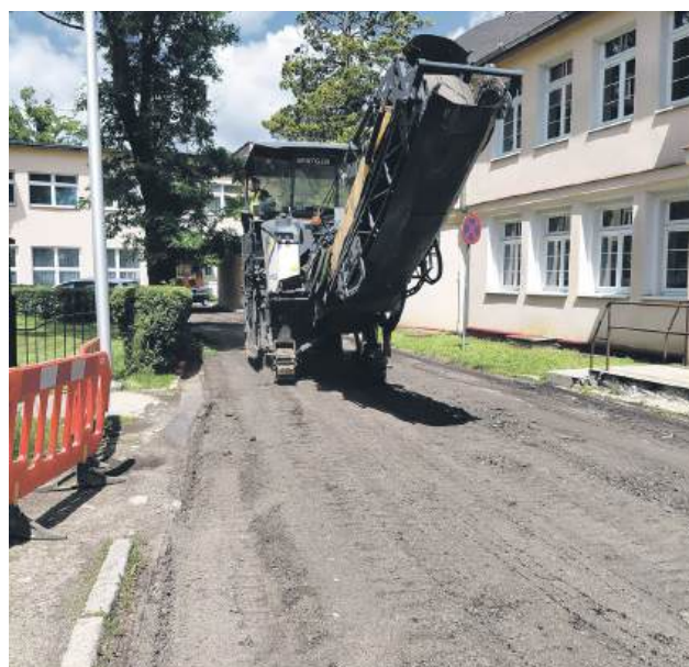
Na zdjęciu fragment remontowanej ulicy Batorego foto z arch. Urzędu Miasta Świeradów-Zdrój
