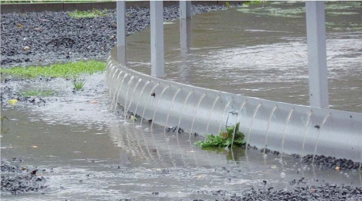
Sytuacja powodziowa na oczyszczalni ścieków z czerwca 2013 roku - przelewają się zbiorniki i zalany jest cały plac oczyszczalni u podstawy zbiorników obsypanych ziemią.
