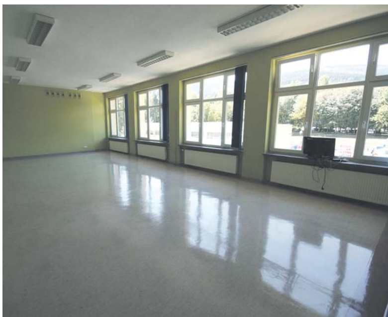
Oto nowy pokój nauczycielski, jeszcze przed wyposażeniem, ale już po polimeryzacji podłóg (co uwidacznia się po świecącej nawierzchni).
