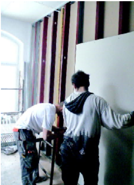
Dzięki steżom montaż ścianek działowych przebiegał szybko i sprawnie.
